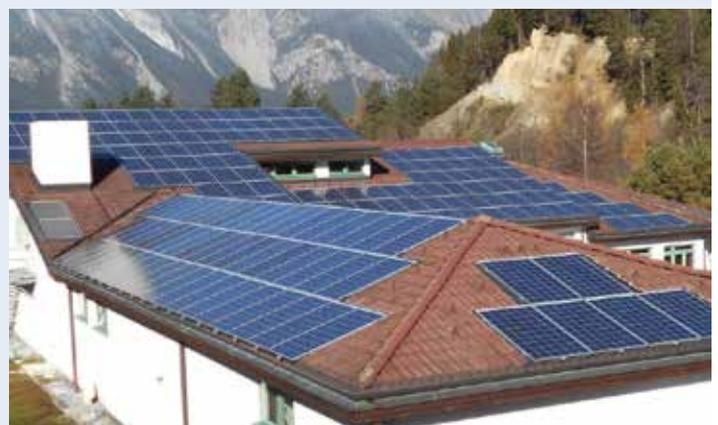
Bei der Kläranlage wurde die Photovoltaikanlage in diesem Jahr fertiggestellt. Die 60 kWp Anlage erzeugt in der Hauptzeit den Strom, der in der Kläranlage gebraucht wird.
