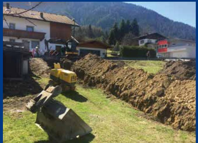
Neuer Weg mit Wasseranschluss wird im Bereich der Dorfstraße bei „Köbelas“ verlegt. In einem späteren Zusammenschluss (Bauland-Umlegung) soll der Weg bis zum Rochus-Stüberl geführt werden.
